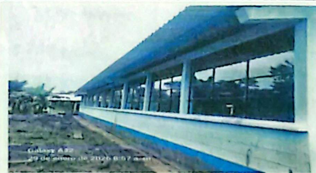
Fotografía 6: Colocación de vidrios en la parte frontal de los modulos.
