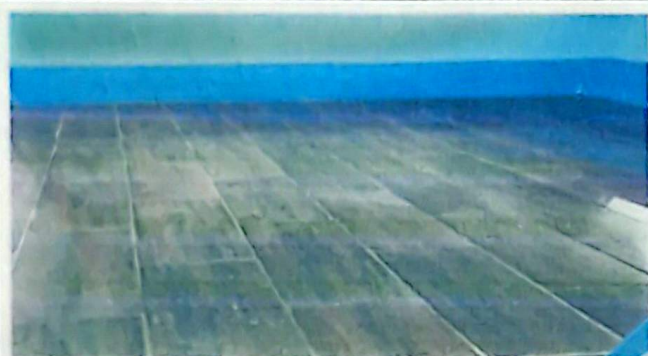
Fotografía 1: Finalización de piso cerámico en modulo I.
