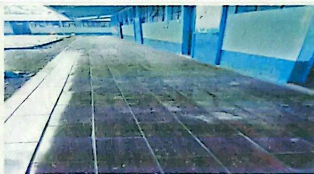
Fotografía 4: Finalización de colocación de piso cerámico de los corredores.
