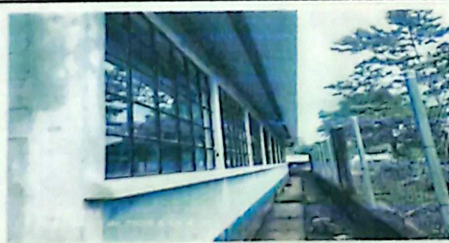
Fotografía 5: Colocación de vidrios en la parte de atrás de los modulos.
